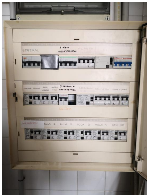
Figura 1. Cuadro de protecciones principal
