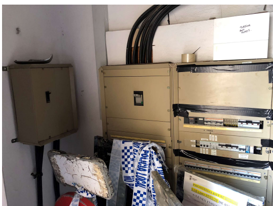
Figura 1. Cuadro de protecciones principal
