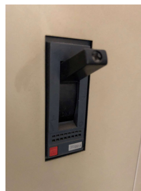
Figura 2. Interruptor general de 250A trifásico
